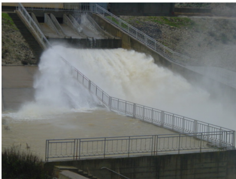
Lâchers d'eau du barrage Sejnane
